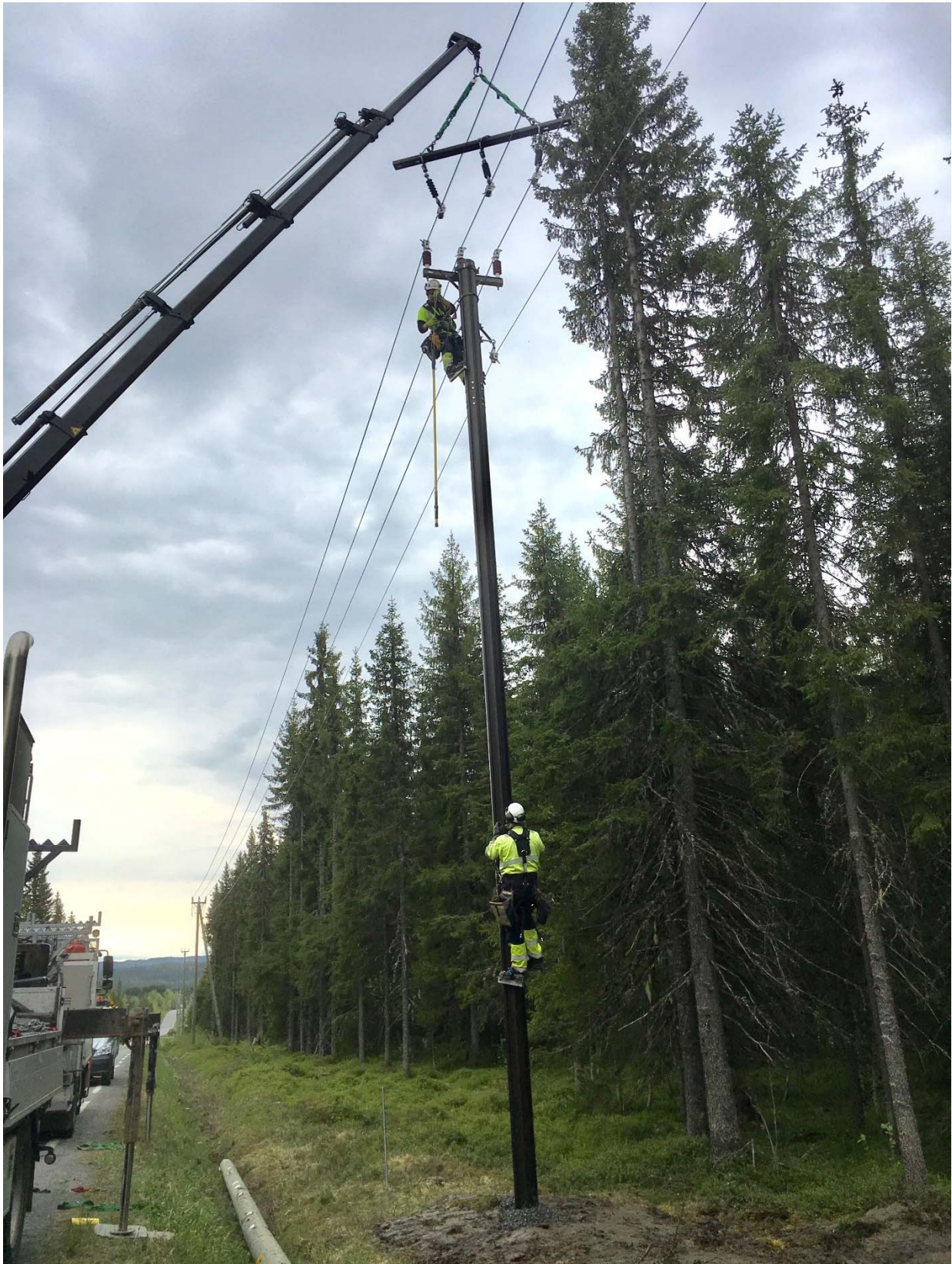
Montering av Norges første aluminiumstolpe.
