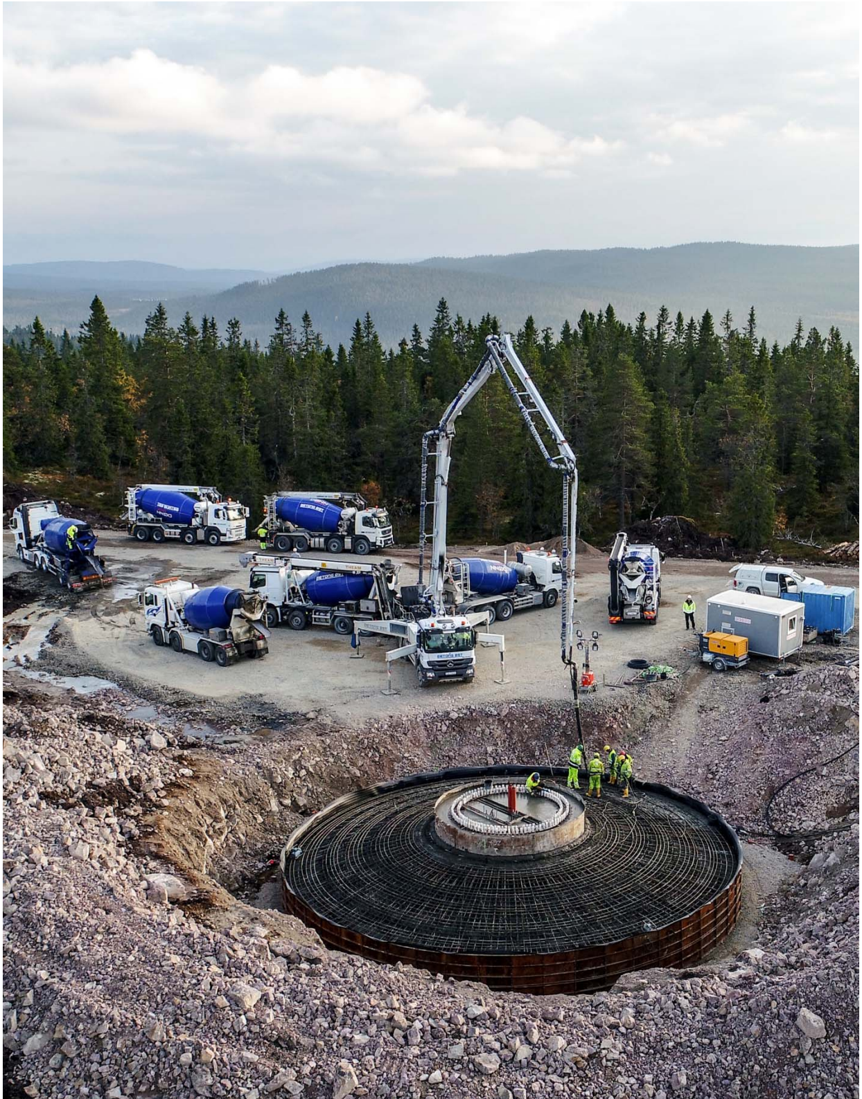
Støping av fundament på Raskiftet vindkraftverk
