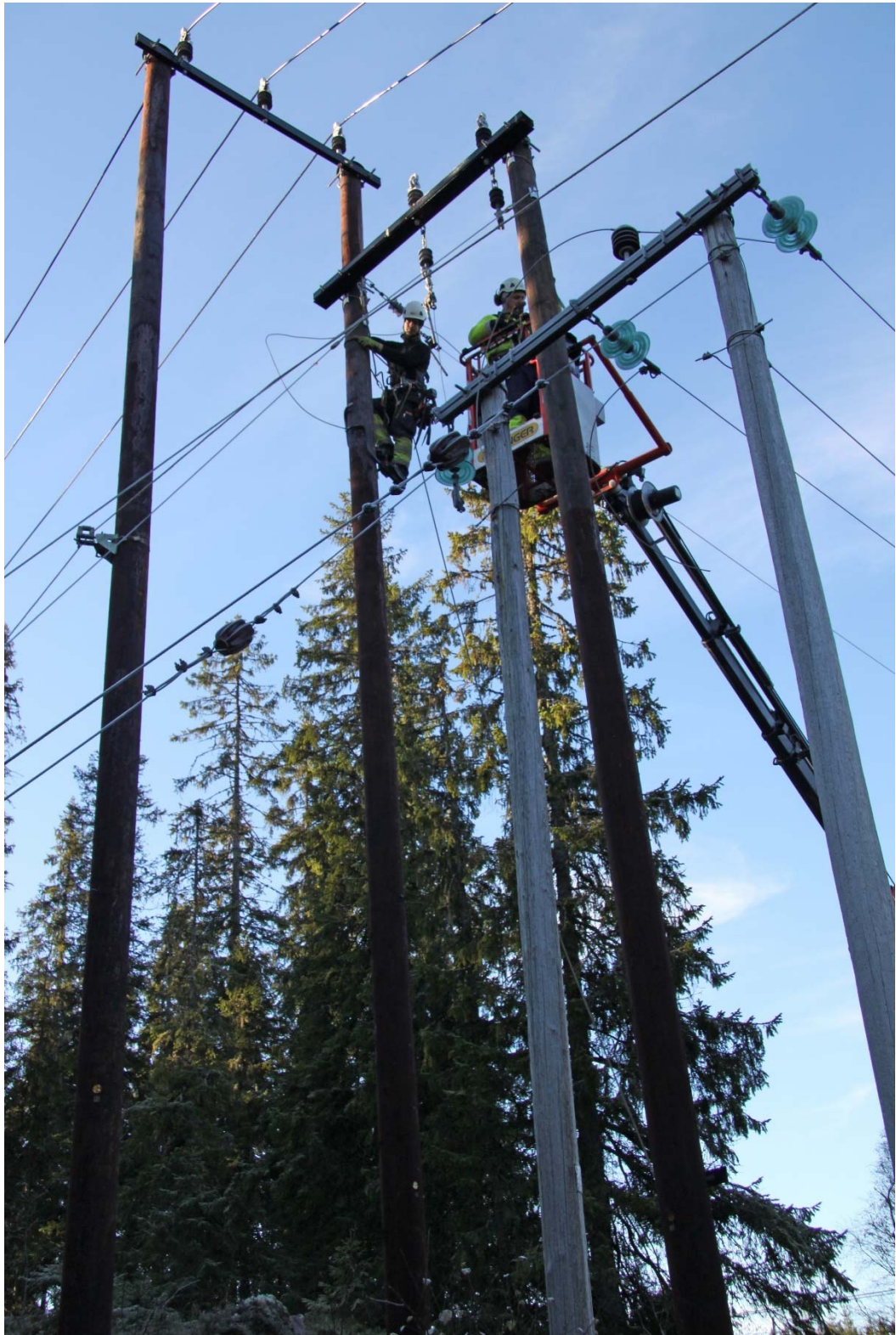
Bygging av ny høyspentlinje i Ringsaker kommune.
