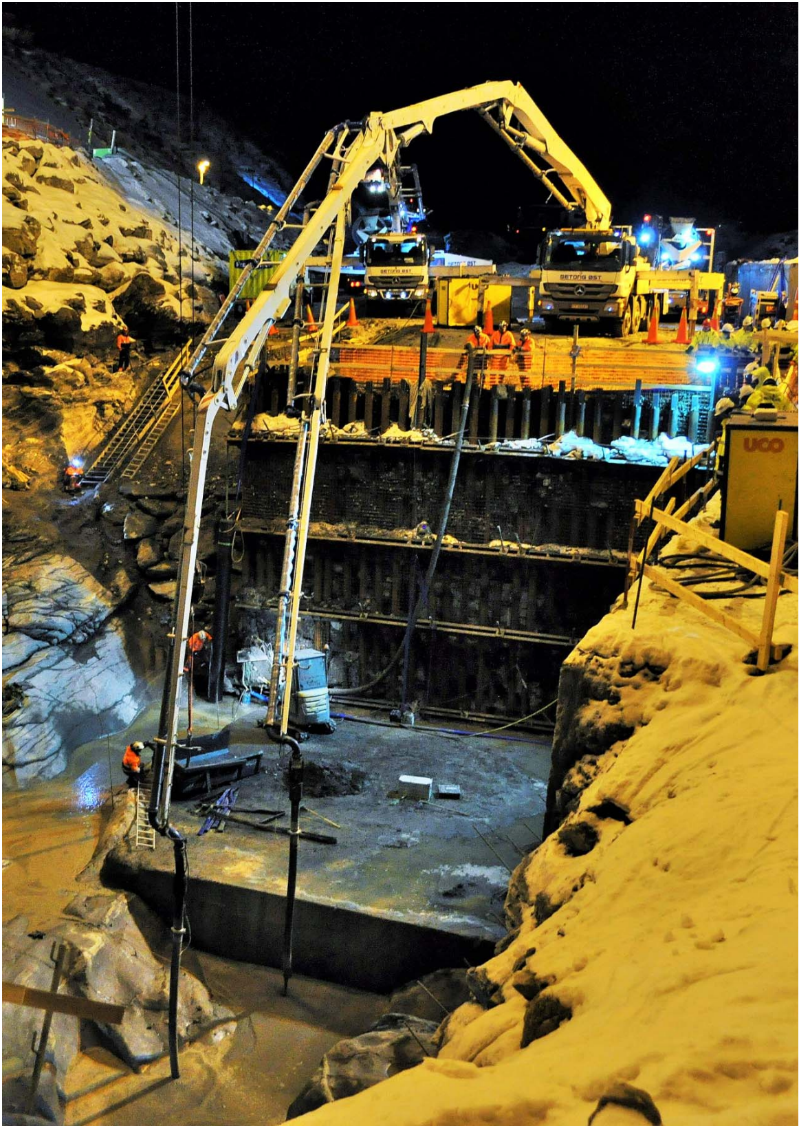
Norges største helkontinuerlige landbaserte betongstøp ble gjennomført på dammen til Rosten kraftverk januar 2017.
