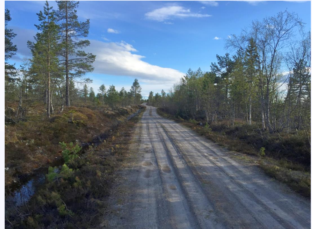
Myrkryssing – tradisjonell skogsbilveg med langsgående åpen grøft
