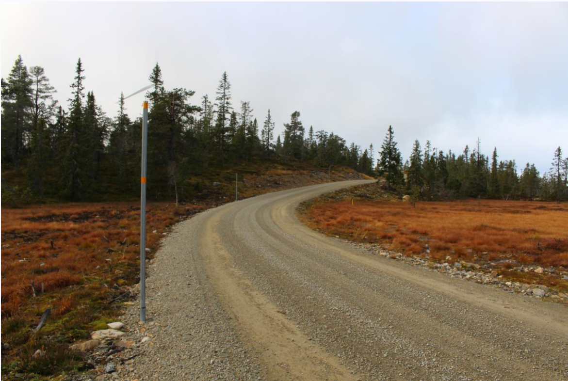
Myrkryssing – anleggsveg Raskiftet
